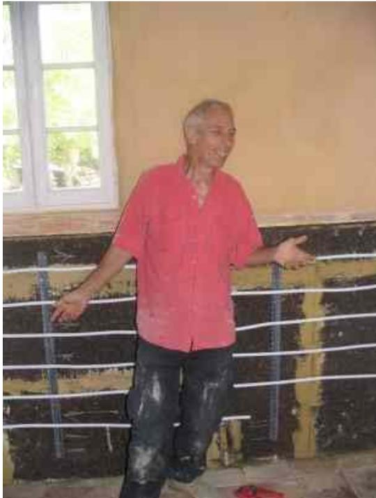
*Les tubes sont fixés sur des panneaux de liège qui sont collés au mur avec un mélange de plâtre et de terre*
