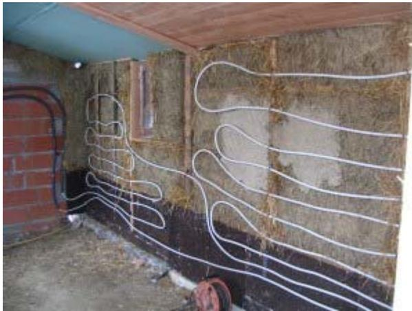
► *Organisation de circuits* Il semble ne pas y avoir de règles pour l'organisation d'un circuit. Nous avons fait des zigzags horizontaux en faisant arriver l'eau chaude par le bas. Ainsi, la partie la plus chaude sera en bas et la convection de l'air chauffera le mur en le léchant vers le haut.
