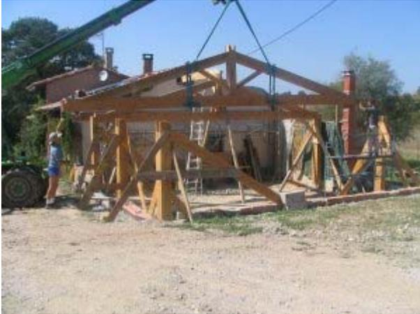
Au fur et à mesure de la pose des fermes, la panne faitière est elle aussi posée. Elle permet de solidariser les fermes.
