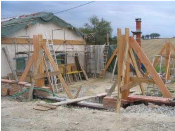
La pose des fermes (800 kg chacune) sur les poteaux a été réalisée avec une grue télescopique en 3 h (à 4 personnes). Elles sont solidement sanglées afin de pas se désolidariser pendant la pose. Une fois posé sur ses poteaux, chaque ferme est provisoirement étayée par deux grand chevrons cloués en croix et calés au sol.
